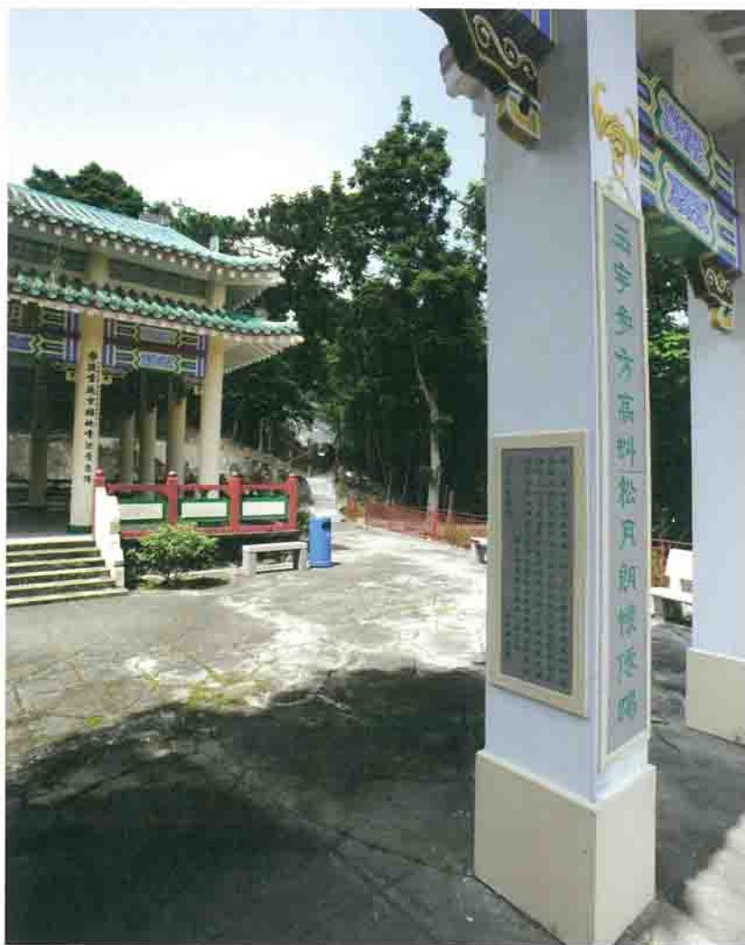
▲ 洞天福地牌坊碑記 現存於館內洞天福地牌坊上
